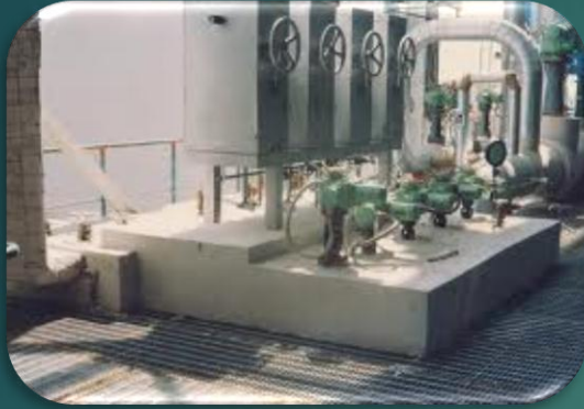
Hydro Power : 230 MW
